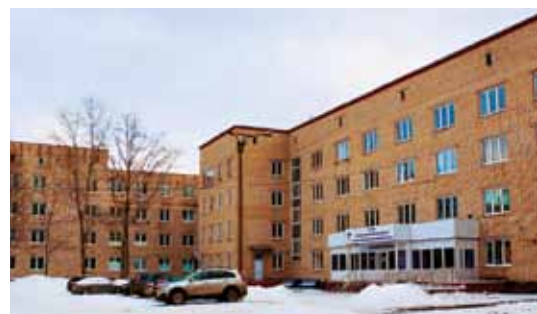
Здание Мордовского республиканского КВД
